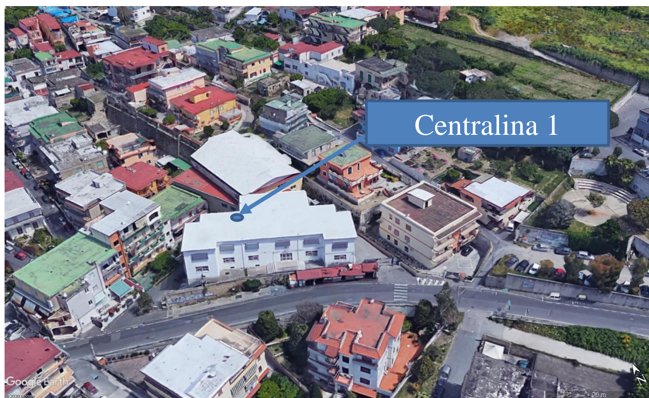
Figura 3. Vista aerea del luogo di installazione della “Centralina 1”.
